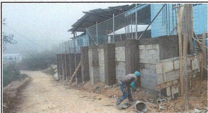
Foto1: limpieza y retiro de tablas del muro realizado.
